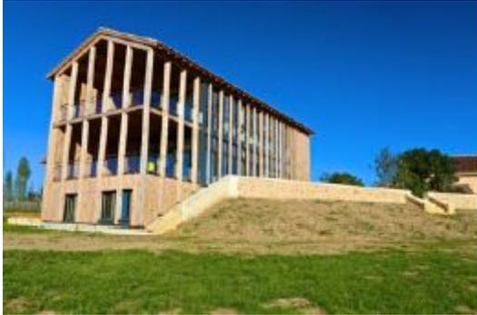
Celle-ci va alors se stocker dans la maçonnerie des murs Nord et Est, en briques micro-alvéolées (résistance thermique de 1), protégées par un puissant isolant extérieur, lui-même recouvert d'un **bardage en bois**.
